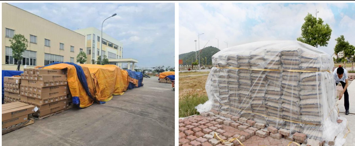
Hình 4.3 Che chắn vật liệu thi công (ảnh minh họa)
