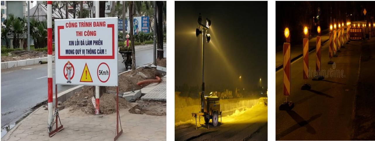
Hình 4. 4 Biển báo, đèn cảnh báo, đèn chiếu sáng trong thi công (minh họa)
